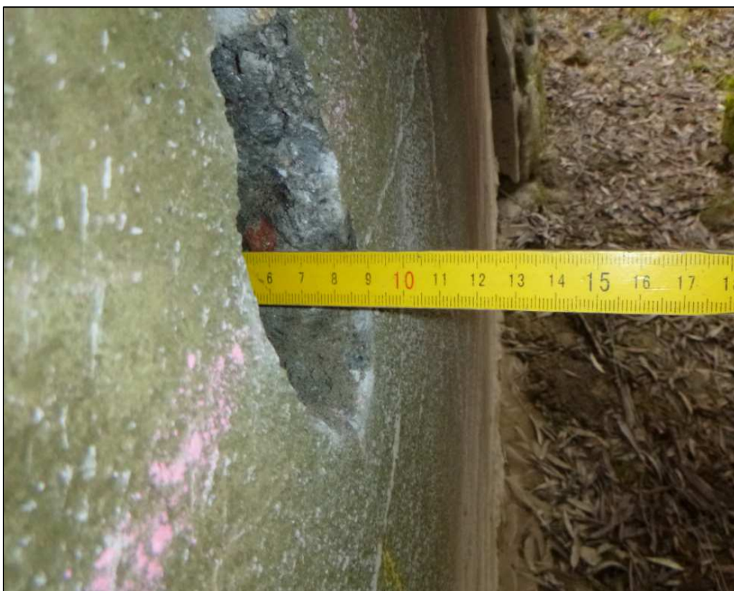
Obrázek 27 – sonda S1, krytí výztuže 85 mm
