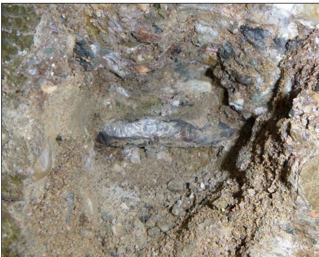
Obrázek 29 – sonda S2, detail vodorovné výztuže
