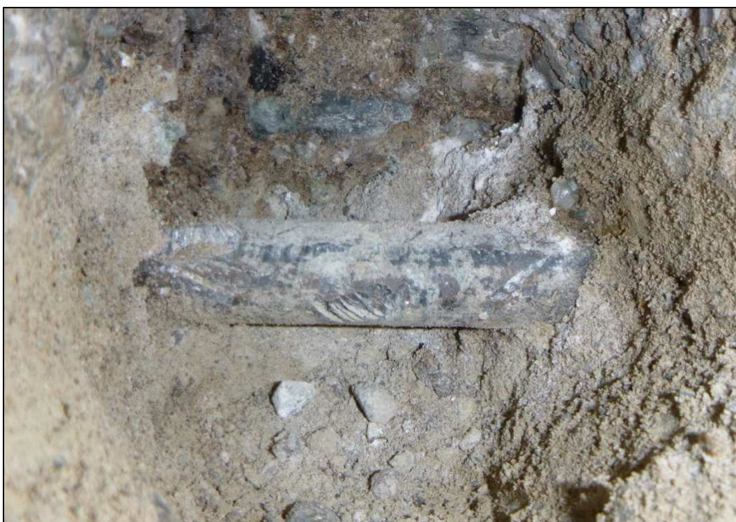
Obrázek 25 – sonda S1, detail vodorovné výztuže, hladký povrch, bez koroze
