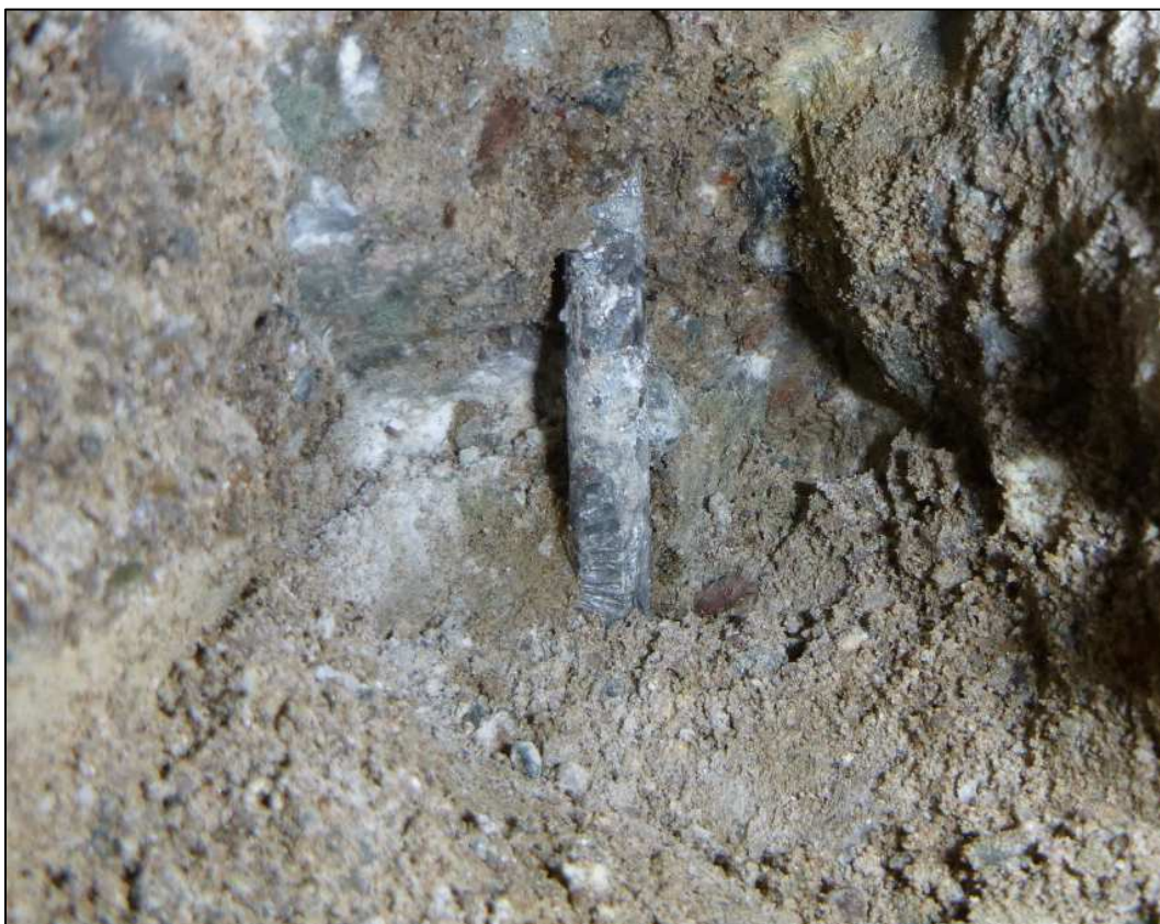
Obrázek 26 – sonda S1, detail svislé výztuže, hladký povrch, bez koroze
