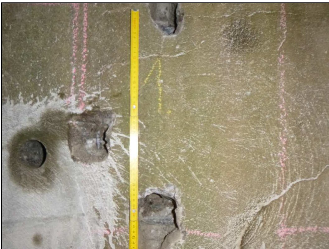
Obrázek 24 – sonda S1 – vodorovná výztuž \varnothing 20 mm, svislá výztuž \varnothing 10 mm, bez korozního úbytku, krytí 80 mm
