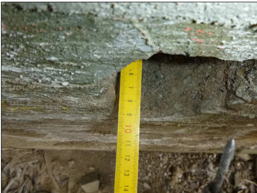
Obrázek 30 – sonda S2, krytí výztuže 80 mm
