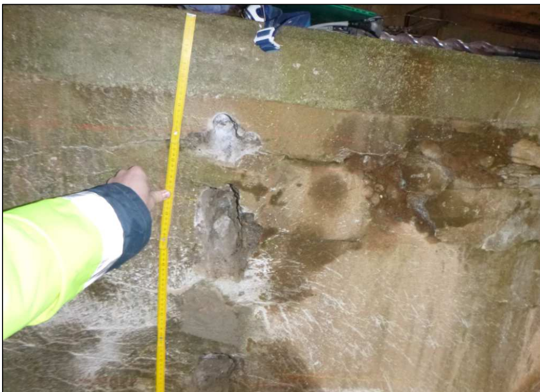
Obrázek 28 – sonda S2 – vodorovná výztuž \varnothing 20 mm, bez korozního úbytku, krytí 80 mm
